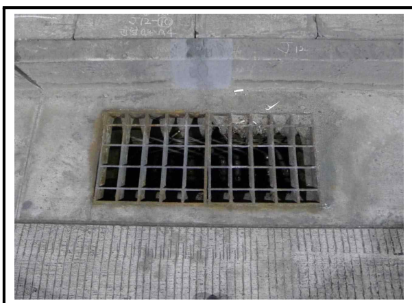
사진번호 11 배수시설 전경 외관망도 -
