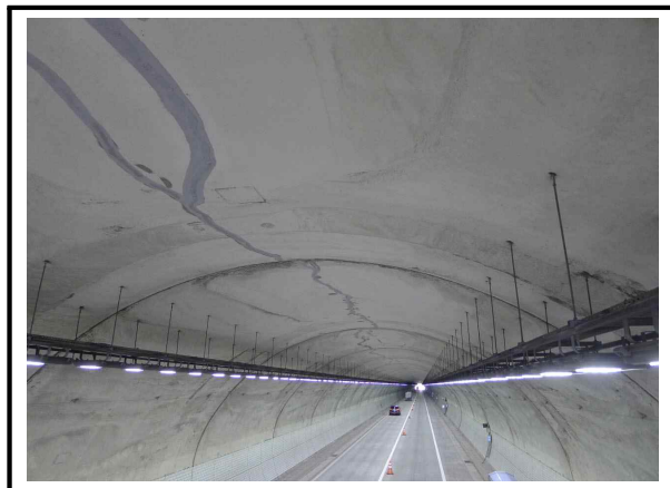
사진번호 8 천단부 전경 외관망도 -
