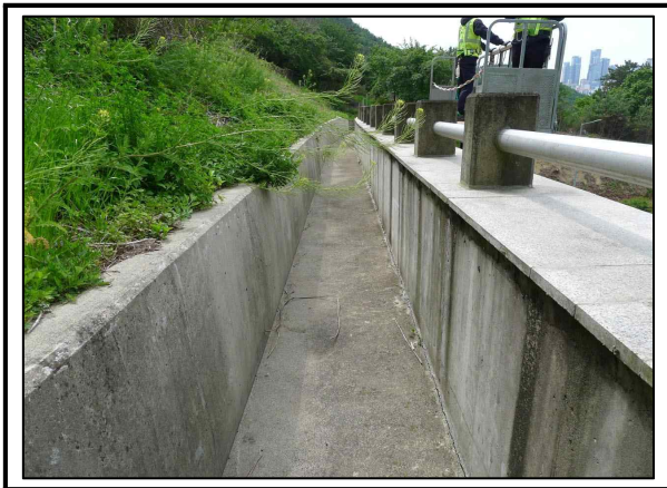
사진번호 79 시점 갱구부 상단 배수로 상태양호 외관망도 -
