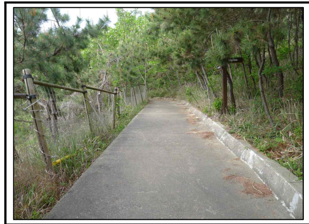
사진번호 80 종점부 사면 소단 배수로 상태양호 외관망도 -
