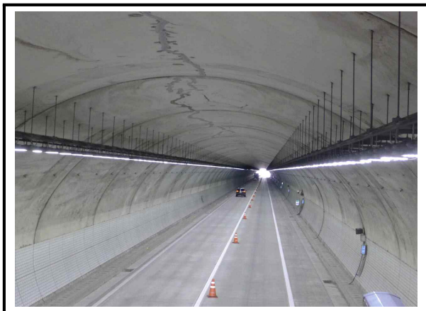
사진번호 7 터널 내부 전경 외관망도 -
